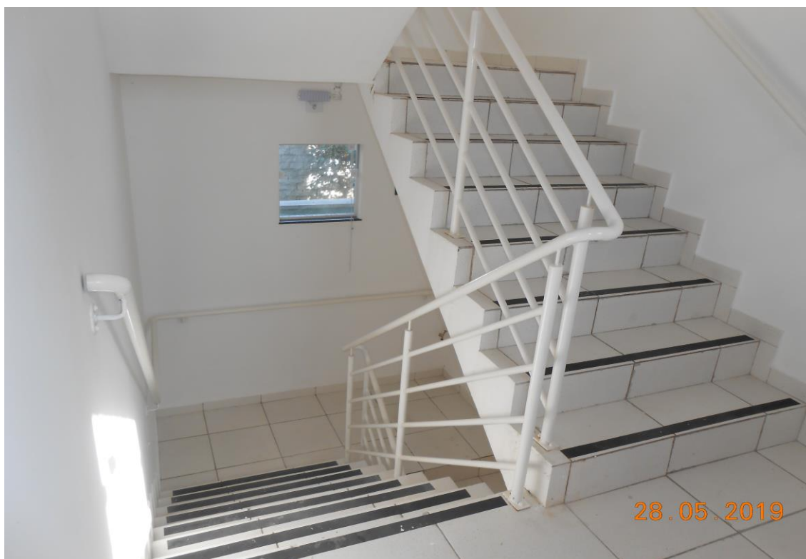
Foto 4: Vista das escadas de acesso aos apartamentos.
