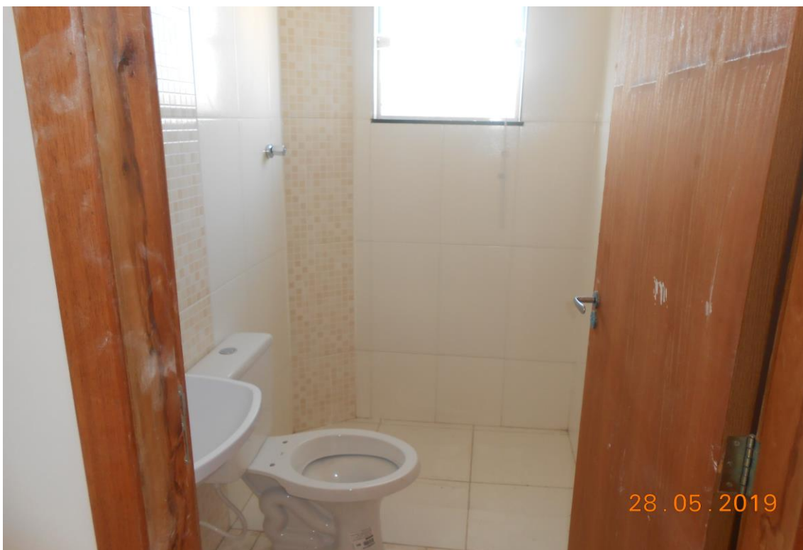
Foto 7: Vista do banheiro.
