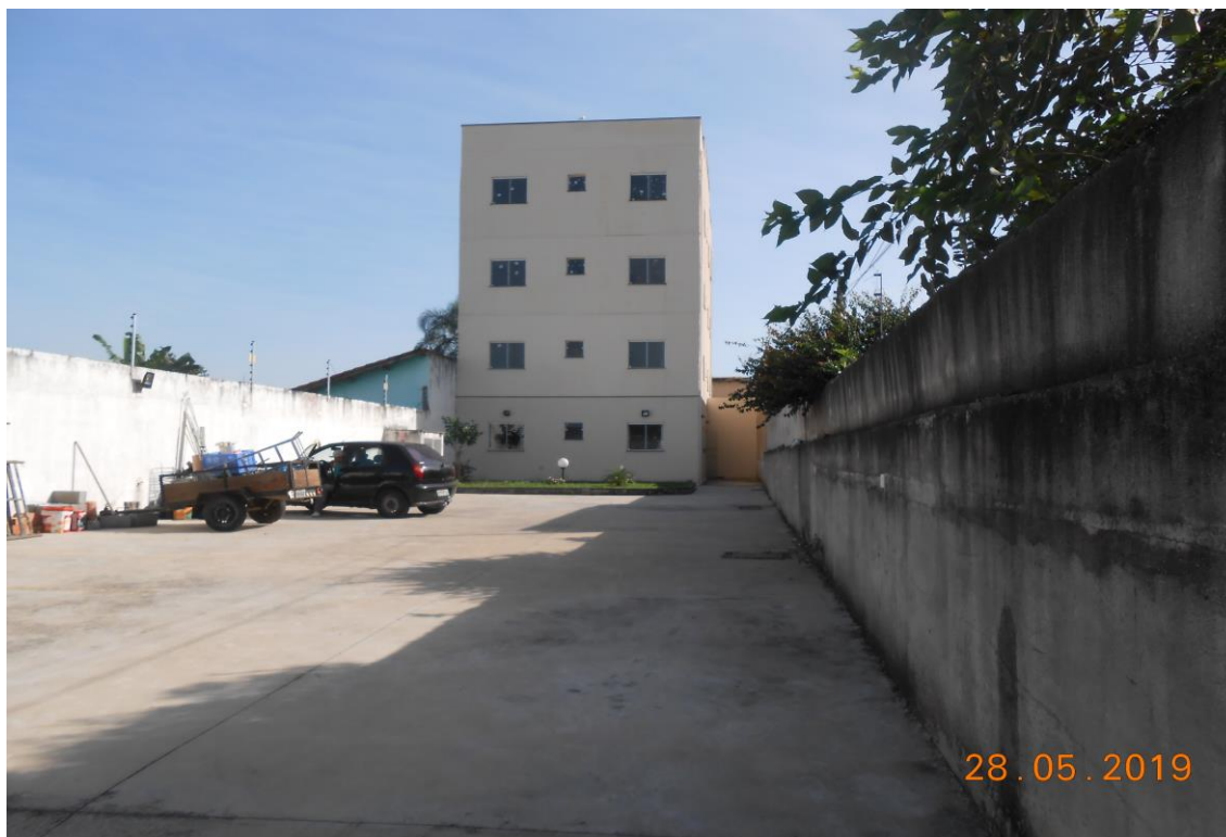
Foto 2 Vista frontal interna do imóvel penhorado.
